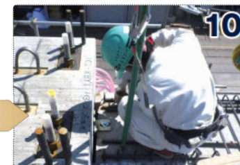
Lắp thanh gia cố trong dầm
