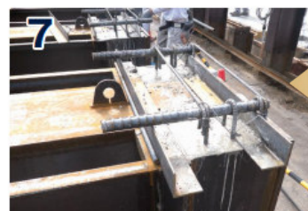
Đổ bê tông phần đầu dầm
