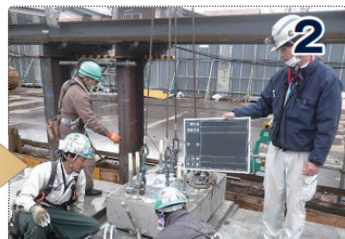
Lắp dựng trụ bê tông
