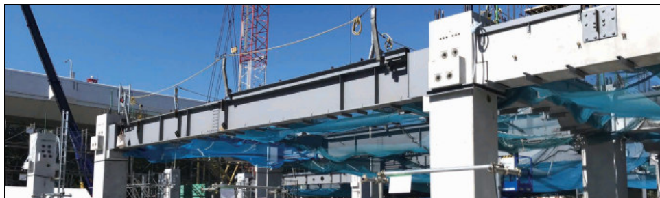
Hình lắp đặt trụ - dầm
